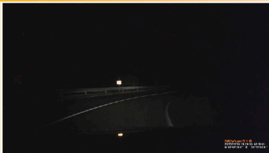
Obr.18 Špatná orientace a vedení v oblouku komunikace
