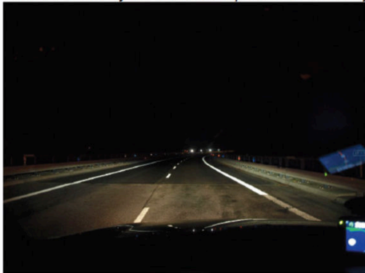
Příklad odrazných vlastností povrchu vozovky a dopravního značení
